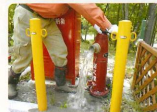
消火栓機能点検
