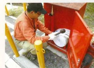
箱内状況点検
