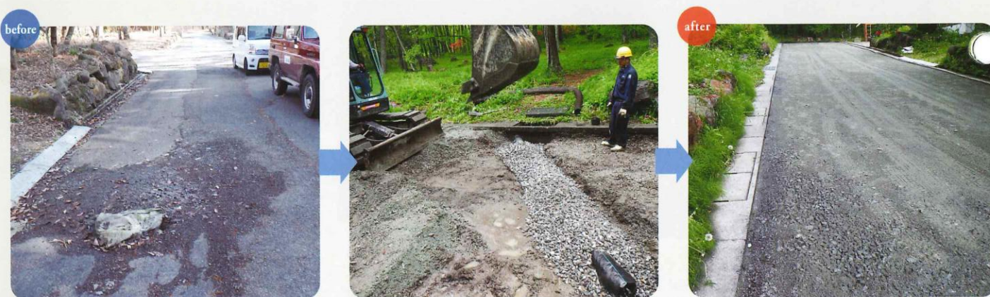
大井ヶ森3期漏水改善工事
