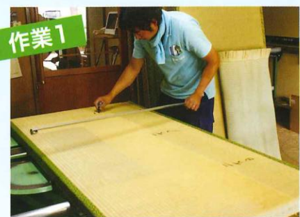
剥がした畳は一つ一つ、微妙に長さが異なるため、サイズを測ります。
