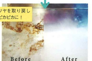
コケつき等は素材を痛めないよう、研磨し磨きます。
