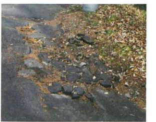
ひび割れや亀裂が生じた場所も補修作業の対象です。
