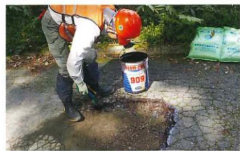
窪んでしまった箇所には上からアスファルトを敷き直しました。
