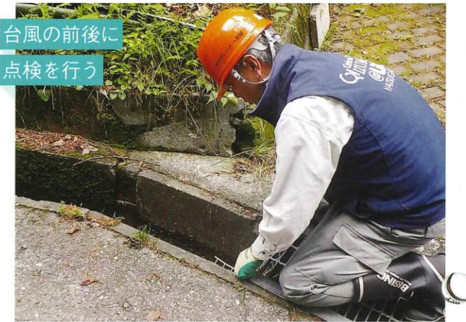
側溝が詰まる恐れがないか確認。
