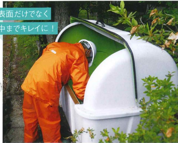
清掃の際には洗剤を用いて、隅々まで手作業で清掃を行いました。
