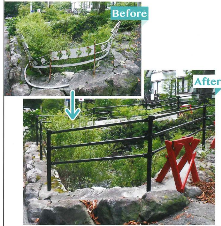
落下事故を未然に防ぐために劣化した柵を取り替えるだけでなく、より強固なものにしました。
