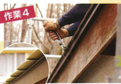
角や端を手作業で加工し仕上げます。小屋根などの立ち上がり部分は特に気を遣います。
