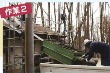
指定の長さで届いた鋼板を現場で加工しながら、屋根に持ち上げていきます。
