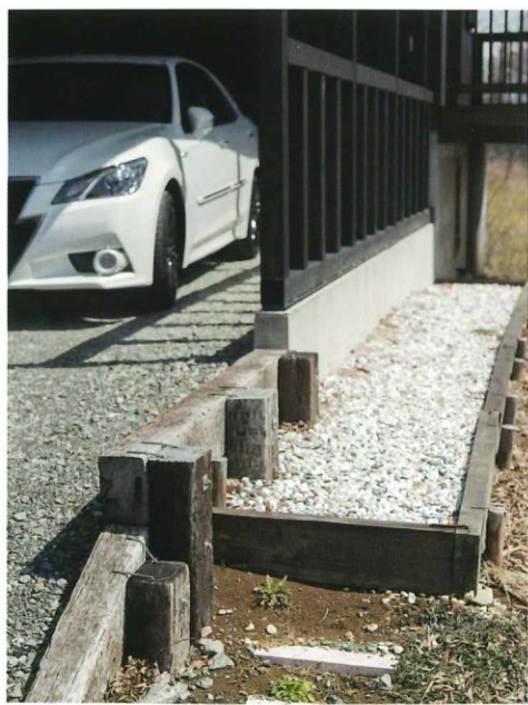
家の周りの犬走りは、野田様自ら試行錯誤して作った。八ヶ岳では自然と体を動かす仕事が残っている。
