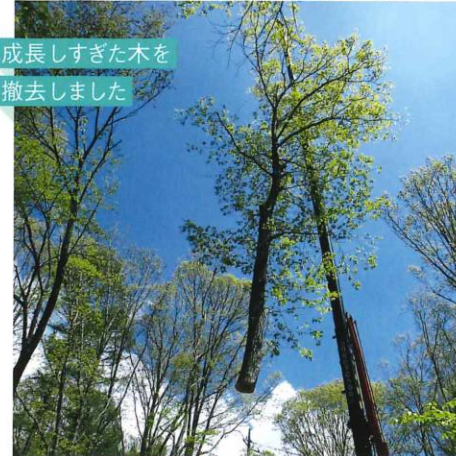
地域の皆様にお声かけをするなど、安全に配慮しながら作業しました。もちろん作業後の清掃も怠りません。
