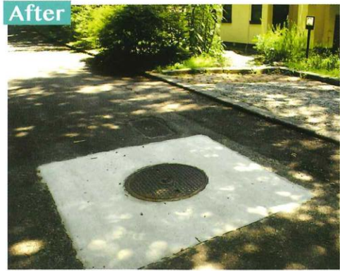
新たにコンクリートを流し込んで、マンホールの高さを元の位置にまで戻しました。
