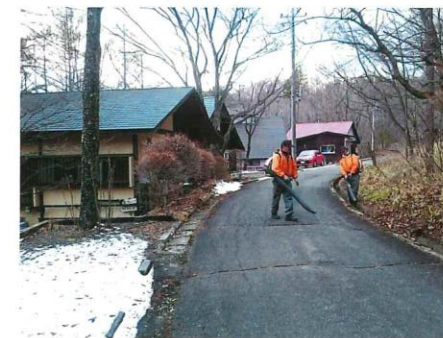
4月はプロアを使用しながら、融雪後の砂利処理を中心に作業を行いました。
